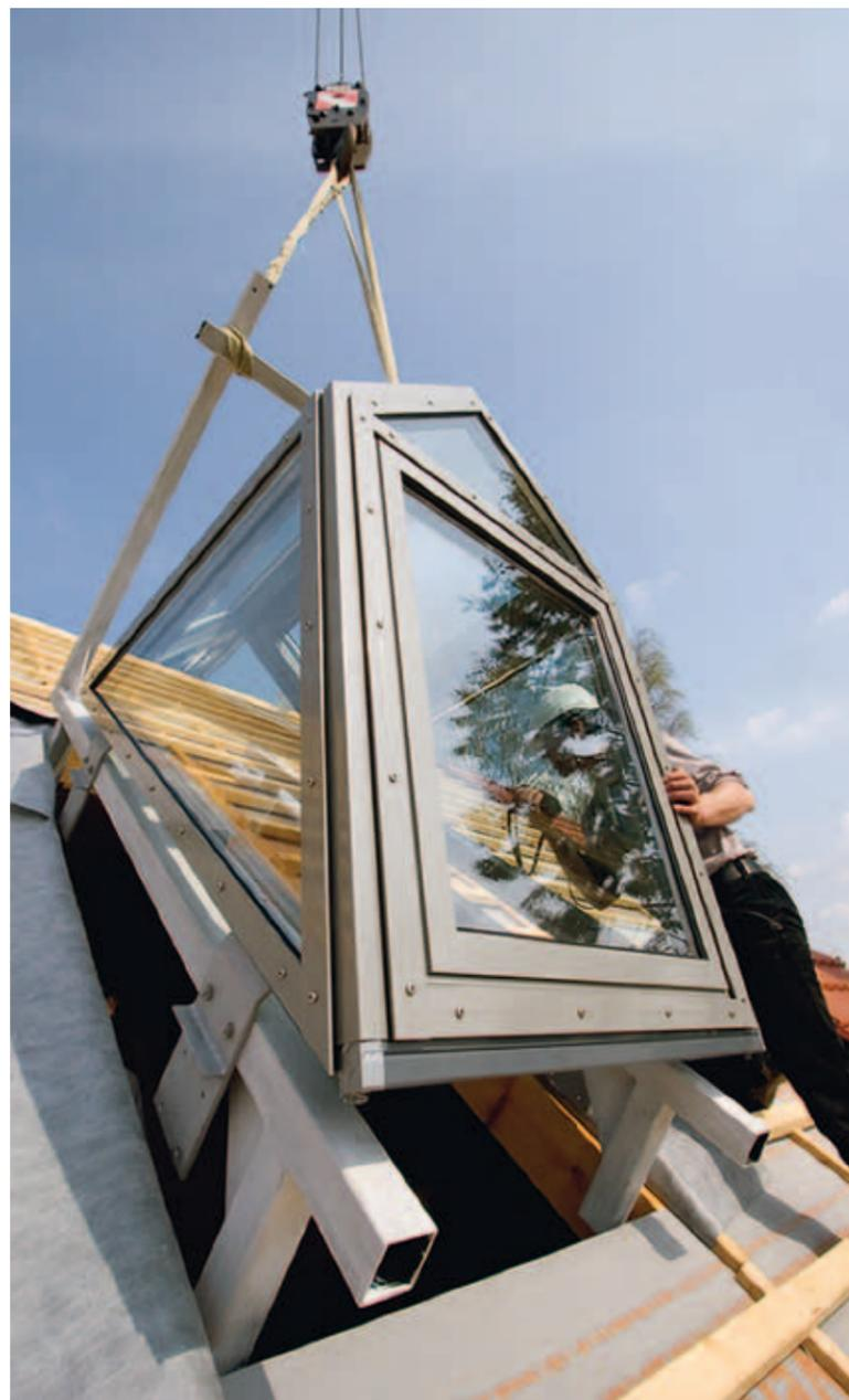
Ob Pult- oder Satteldachgauben – LUXIA® gewährleistet eine einfache, schnelle und qualitätsgesicherte Ausführung der Montage. Die Gaube wird aufsatz- und anschlussfertig geliefert und kann in weniger als 30 Minuten montiert werden.
